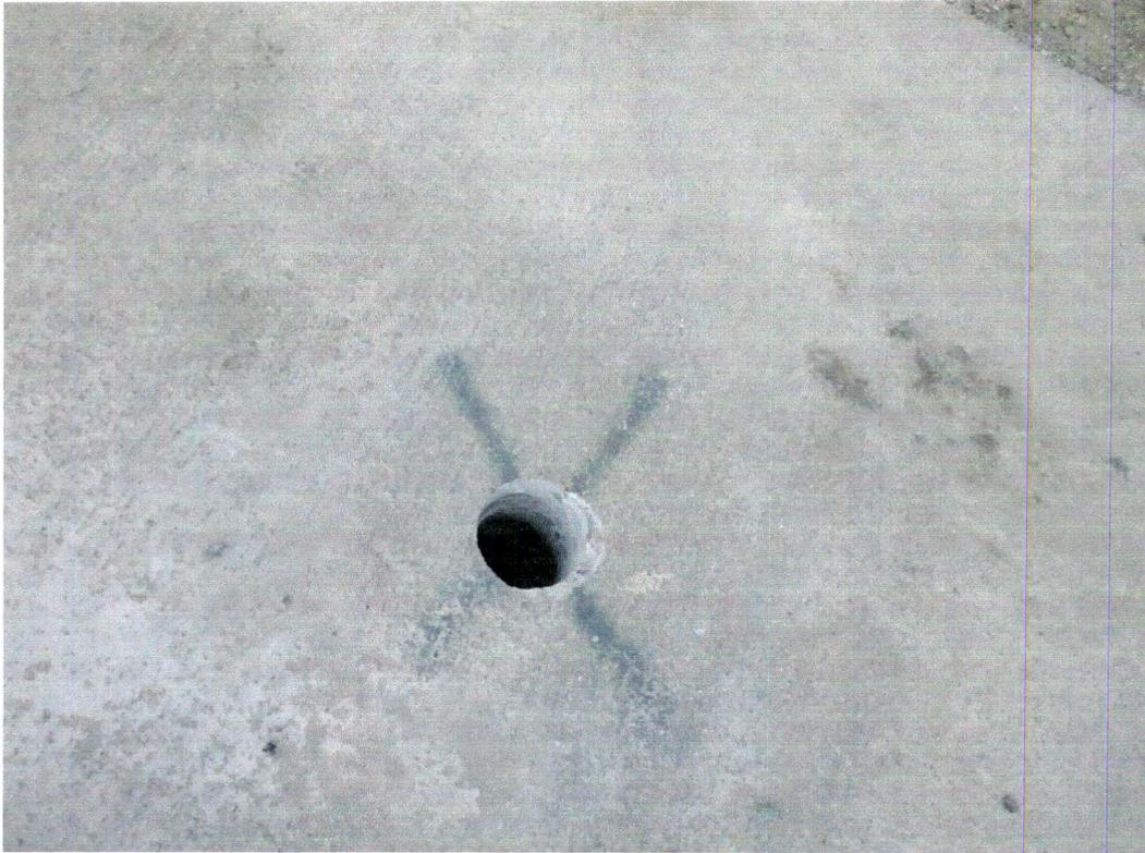
**Imagen N° 15 – Falta retape de extracción de testigos**
