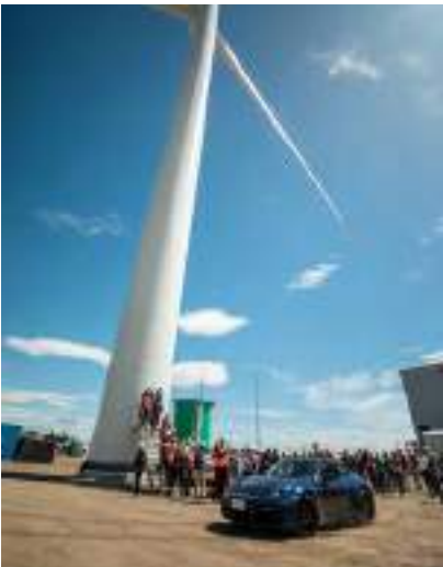
➡ En diciembre del 2022 se inauguró en Punta Arenas la primera planta totalmente integrada del mundo para la producción de combustibles CO 2 neutrales a base de hidrógeno verde.
