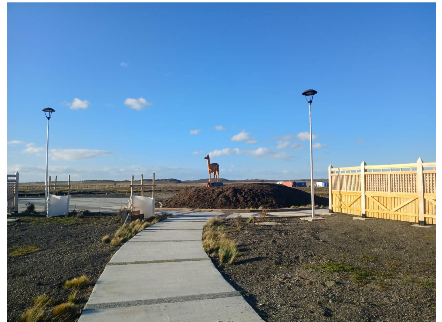
Construcción Plaza de Bolsillo Pampa Guanaco
