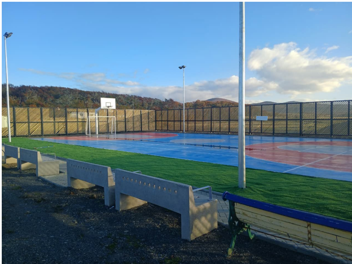
Construcción Multicancha Pampa Guanaco
